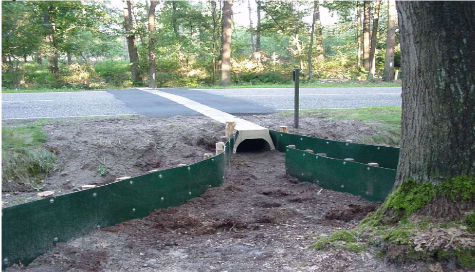
Een van de amfibieëntunnels bij de Klotterpeel
